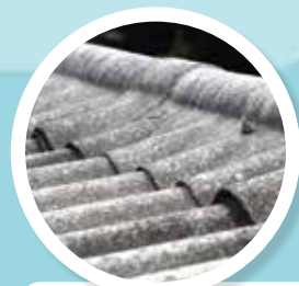
GOLFPLAAT Asbestcementen golfplaat van ongeveer 5 mm dikte. Lichtgrijs of gekleurd (zwart of rood).
