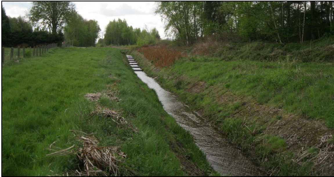
De betonnen sleuf met op de achtergrond de bodemvallen.
